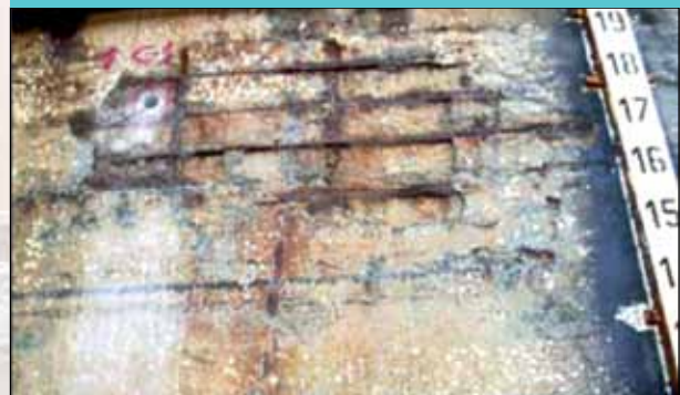
Коррозия в результате воздействия хлорида
