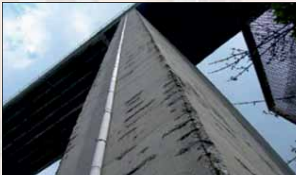
Повреждения в результате агрессивного воздействия сульфатов
