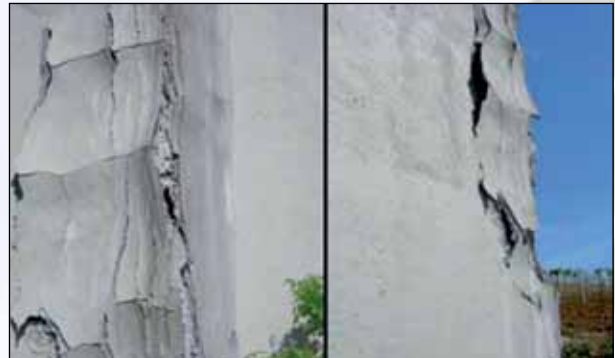
Повреждения в результате агрессивного воздействия сульфатов
