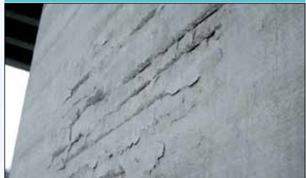
Разрушение сооружения вследствие коррозии арматурных стержней
